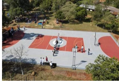
Plaza 25 de noviembre: construcción de vereda
