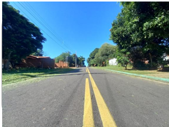
Proyectos de asfaltado en tramos céntricos
